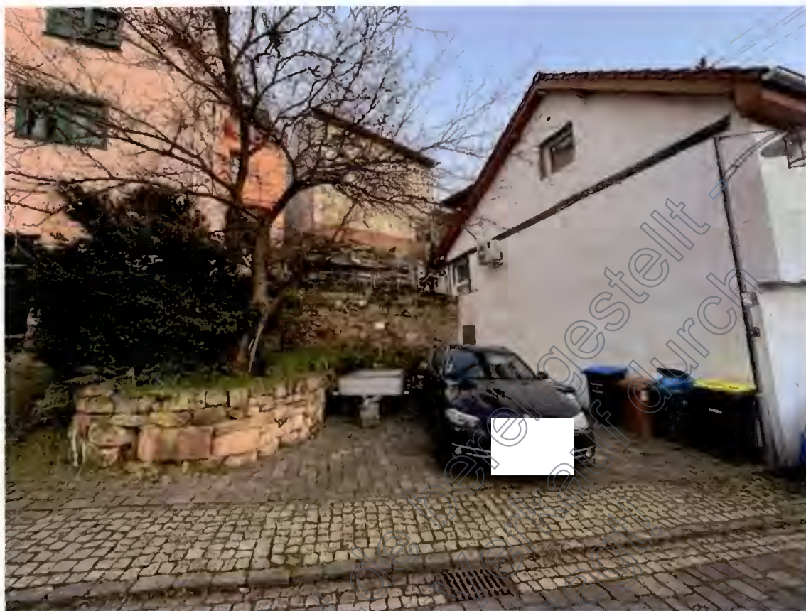
Giebelansicht (der Stellplatz liegt auf dem Nachbarflurstück 480)
