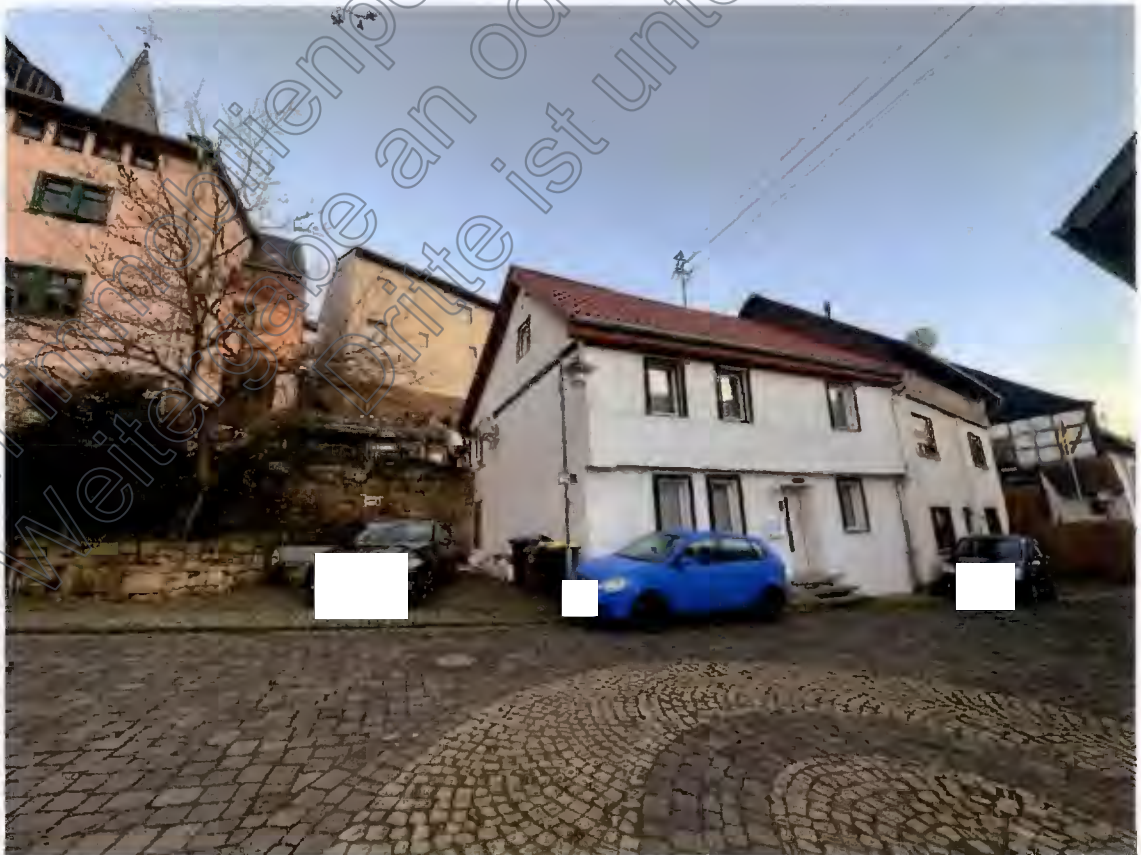
Straßenansicht von Nordwest
