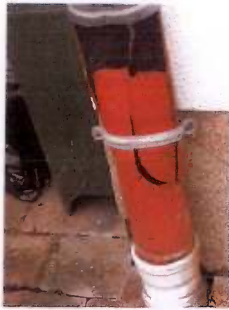
Schadhaftes Regenfallrohr
