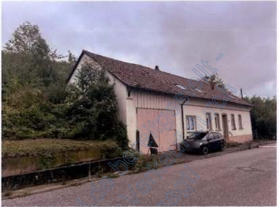
Wohngebäude Straßenseite von Westen
