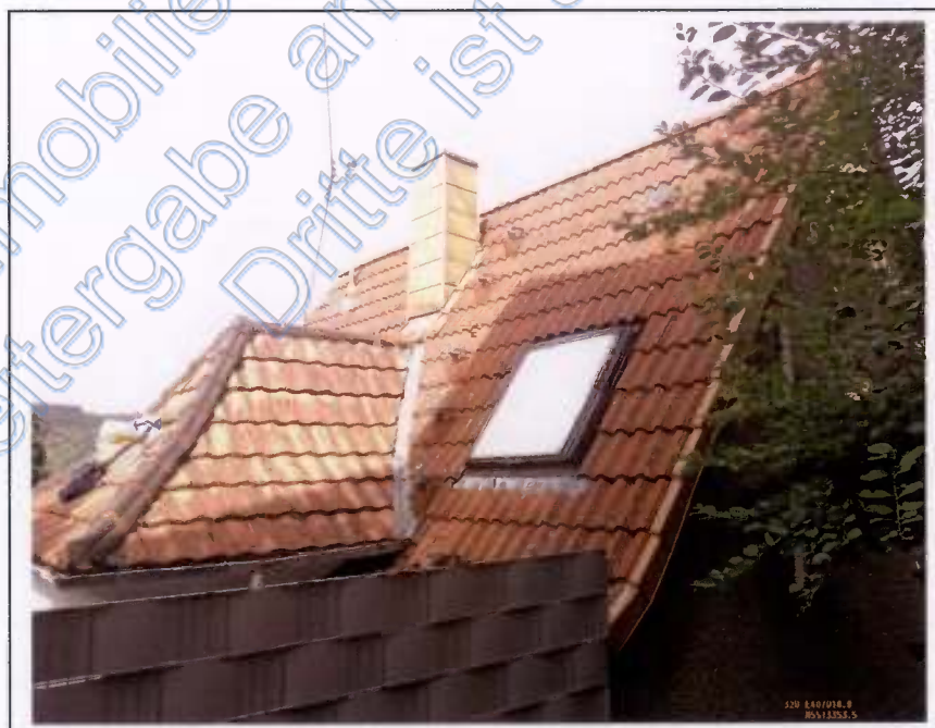
Foto 10 Teilansicht Dach Wohnhaus Nr. 12 A
