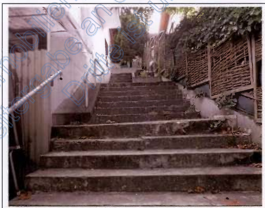
Foto 6 Außentreppe Westseite KG/EG
