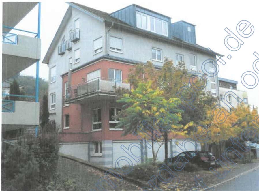
Straßenansicht Körnickestraße von Osten
