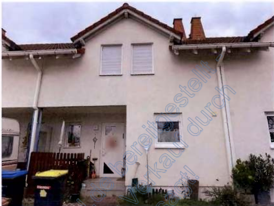
Zufahrtsseite von Nordwesten
