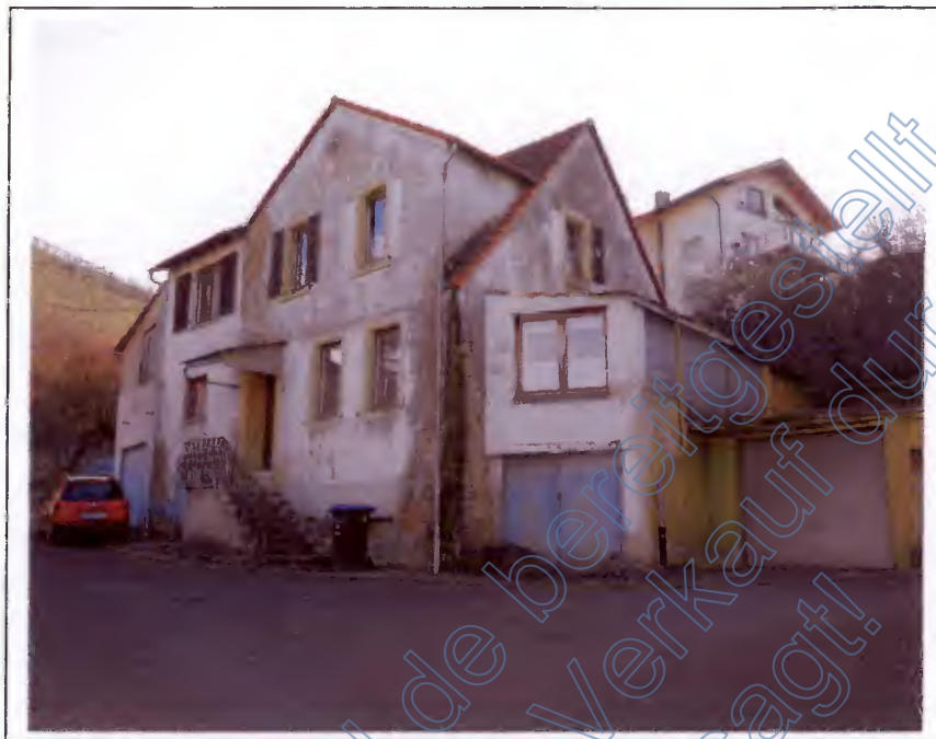
Foto 1 Wohnhaus mit seith. Anbauten Straßenansicht (NW-Seite)
