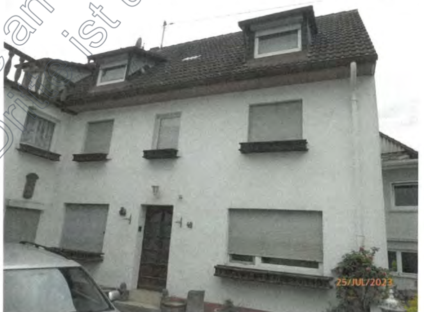
Ansicht von Osten
