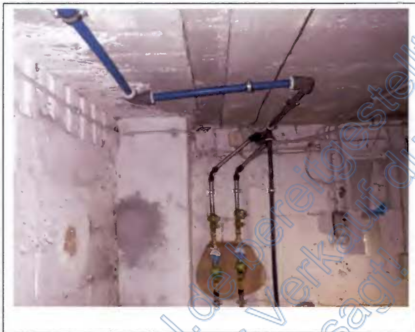
Foto 17 Zuleitung Wasseranschluss
