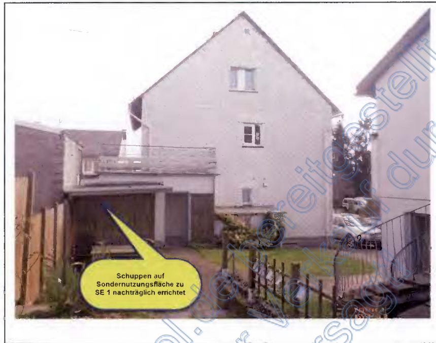
Foto 7 SE Nr. 1: Schuppen nachträglich errichtet
