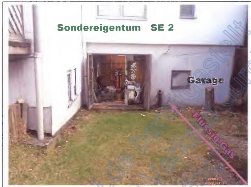
Foto 15 Rückwärtige Ansicht von SE 2 mit Garage und Durchfahrt
