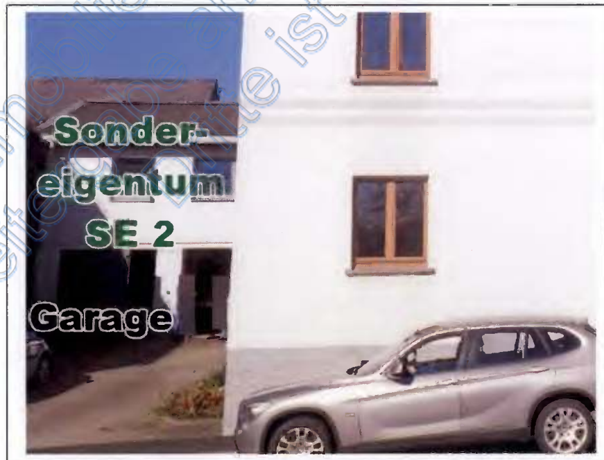
Foto 14 Die Gas-Therme zu SE 2 befindet sich in der Garage
