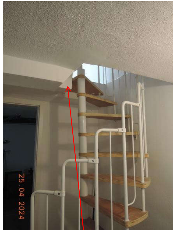
Bild 25: Spindeltreppe und abgeschnittener Deckenträger im Kellergeschoss
