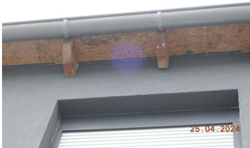
Bild 33: Dachüberstand mit OSB-Platten
