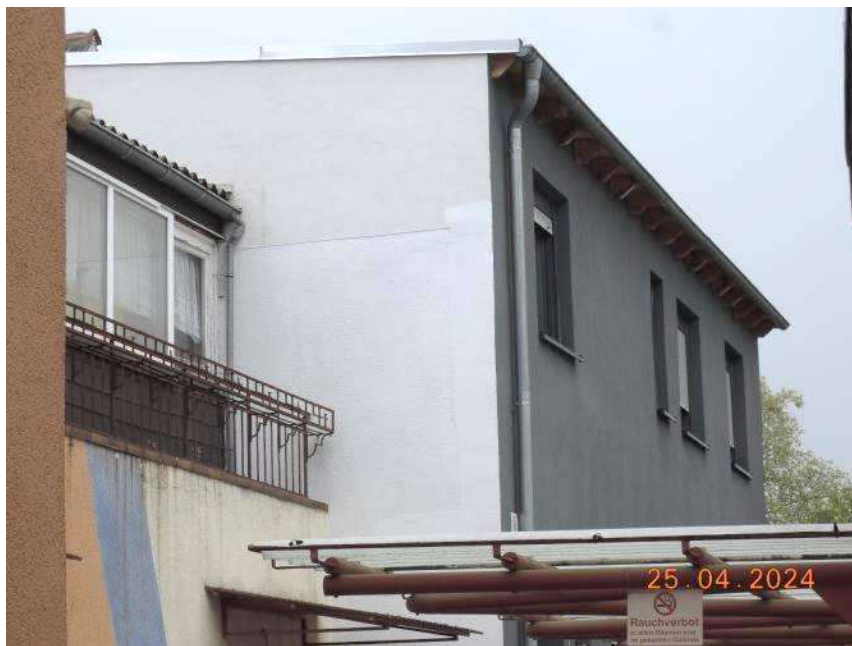
Bild 3: Obergeschoss mit Ansicht von Nordwesten
