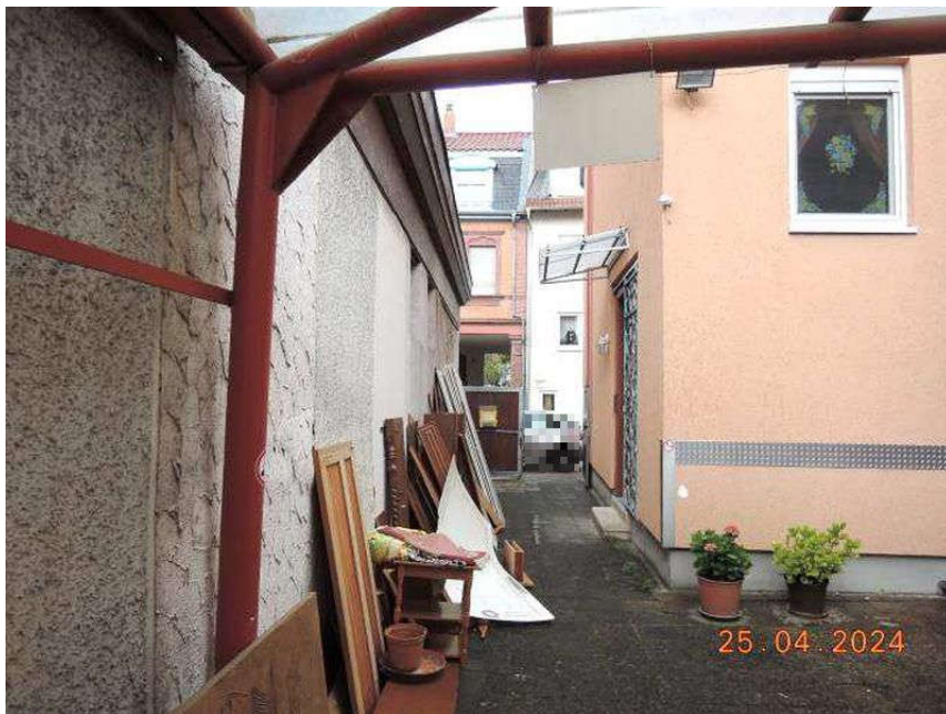
Bild 7: Blick vom Grundstückszugang/Innenhof zur Merianstraße
