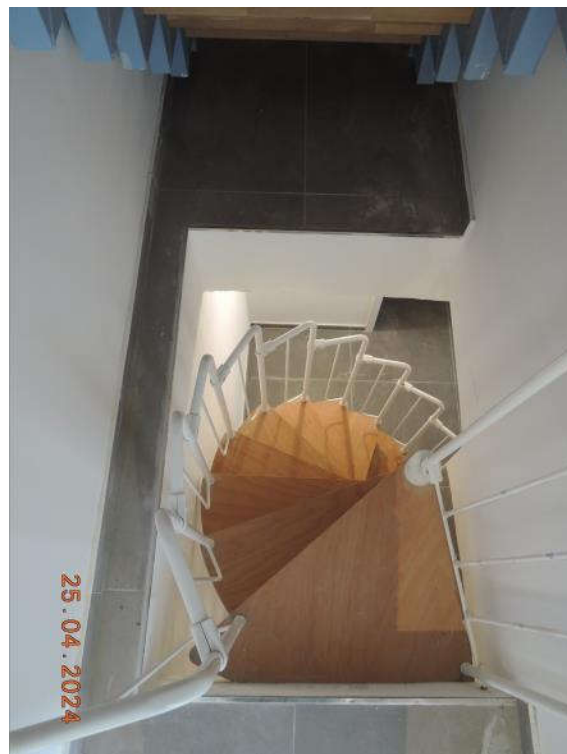
Bild 24: Spindeltreppe vom Erdgeschoss in das Kellergeschoss
