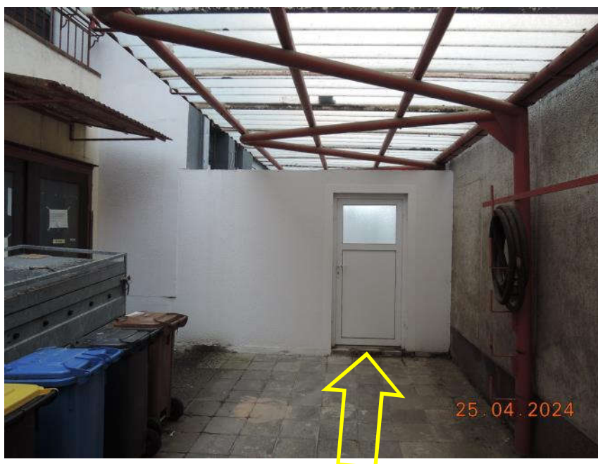
Bild 6: Innenhof mit Grundstückszugang
