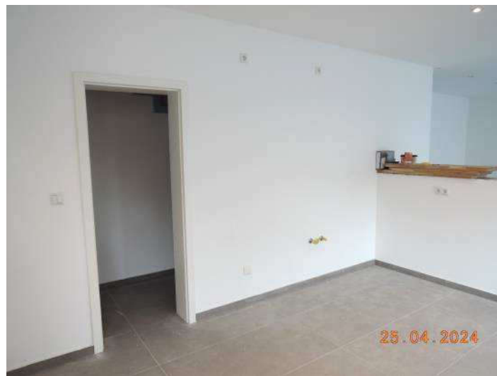
Bild 23: Zugang vom Erdgeschoss zum Kellergeschoss
