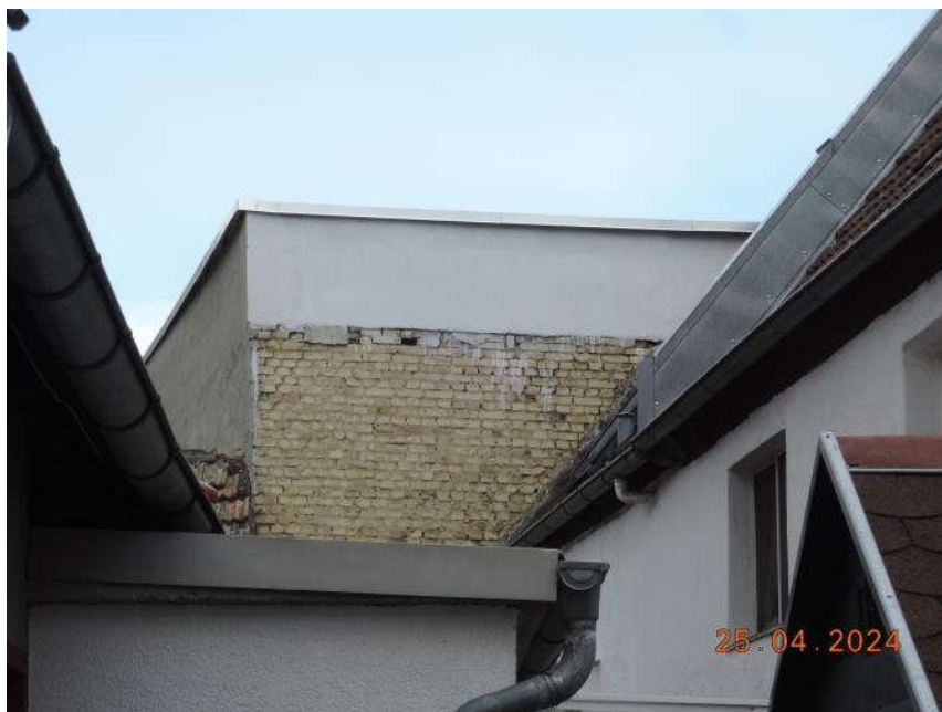
Bild 4: Gebäuderückseite (OG) mit Ansicht von Osten (Schlossgasse)
