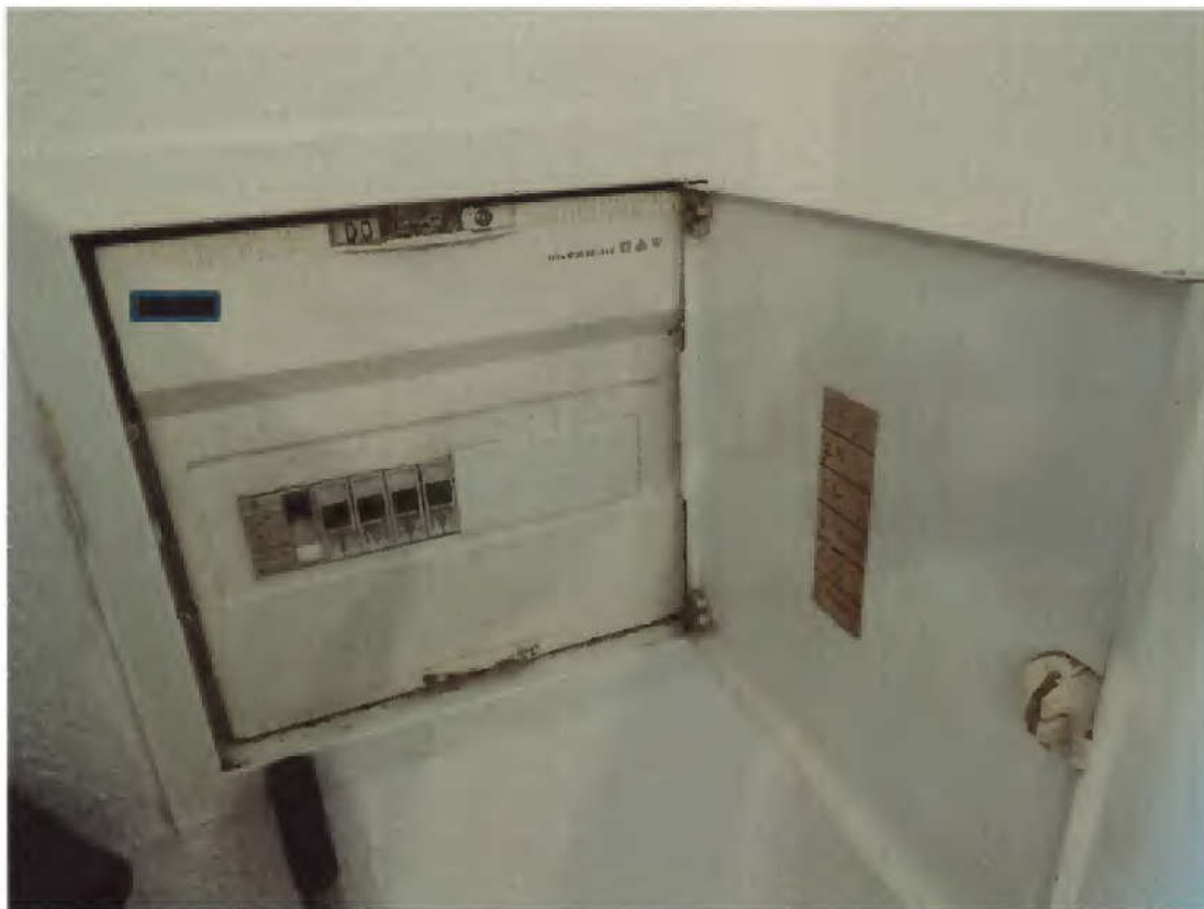
Sicherungskasten
