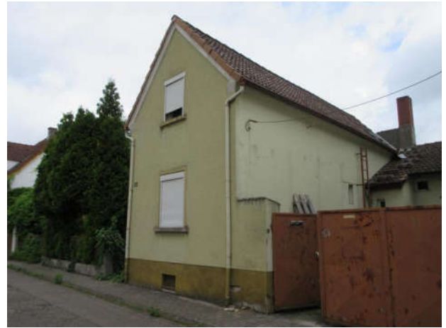
Straßenfassade und Südostansicht Wohnhaus
