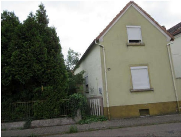
Straßenfassade und Nordwestansicht Wohnhaus
