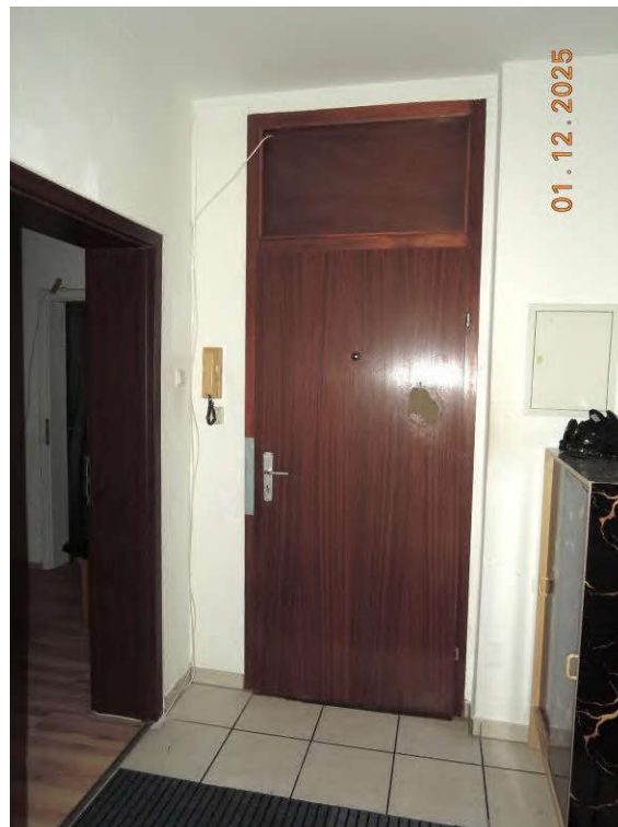
Abb. 17: Wohnungseingang der Wohnung im 1. Obergeschoss (rechts)
