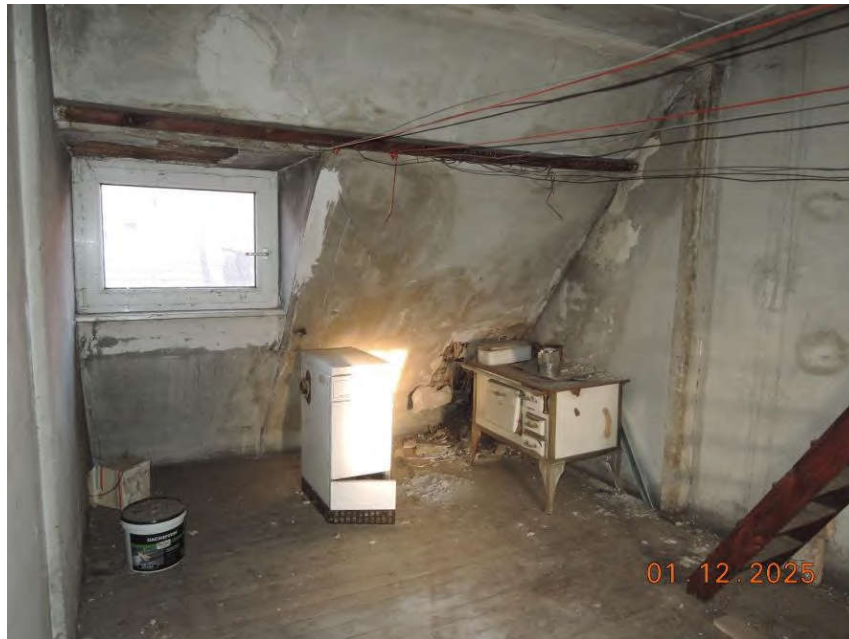
Abb. 27: Dachgeschoss mit Treppe zum Speicher
