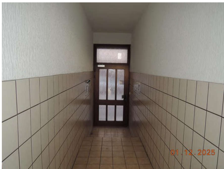
Abb. 2: Hauseingangsbereich und Flur
