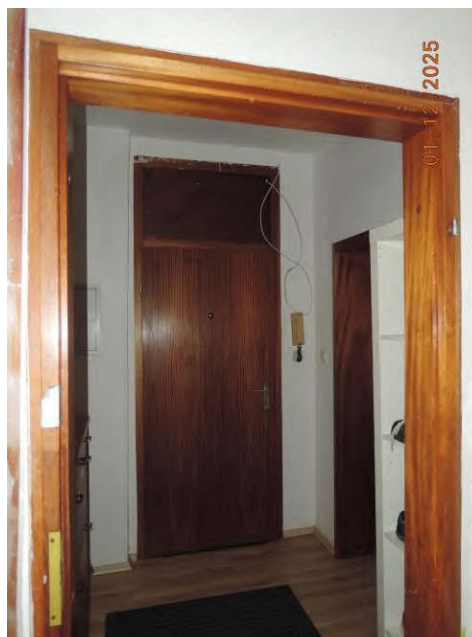
Abb. 22: Wohnungseingang der Wohnung im 1. Obergeschoss (links)
