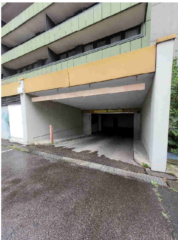
Aufnahme 12: Einfahrt Tiefgarage
