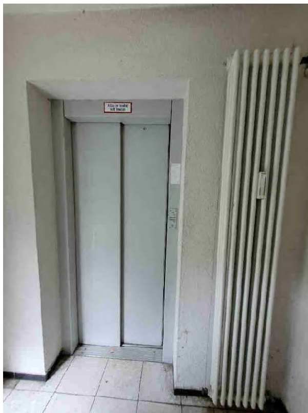
Aufnahme 7: Personenaufzug Heinigstraße
