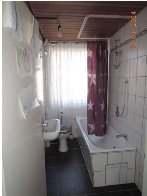
Abb. 11: Bad der Wohnung im Obergeschoss
