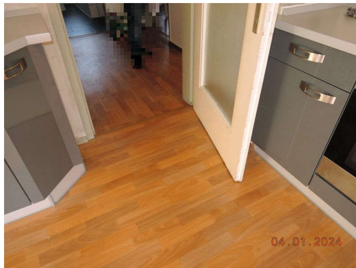
Abb. 10: Detailaufnahme (Küche zum Flur) der Wohnung im Obergeschoss
