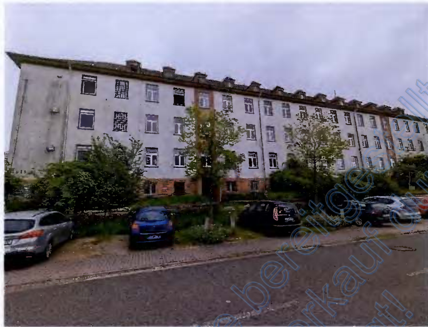
Bild 1: Ansicht Delaware Avenue
