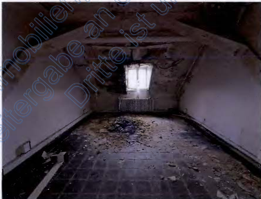
Bild 12: Dachgeschoss, Feuchtigkeitsschäden
