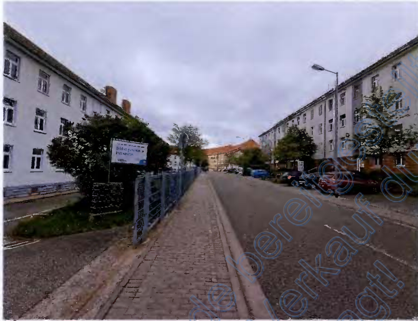
Bild 3: Blick in die Delaware Avenue
