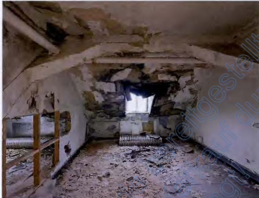
Bild 13: Dachgeschoss, Feuchtigkeitsschäden
