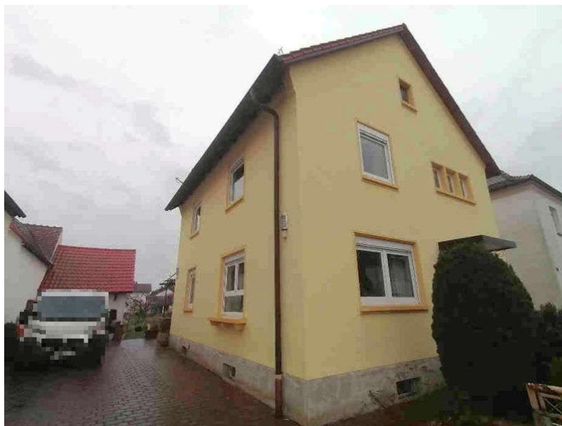
Aufnahme 2: Ostansicht und Hofzufahrt
