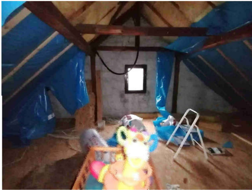
Aufnahme 7: nicht ausgebautes Dachgeschoss
