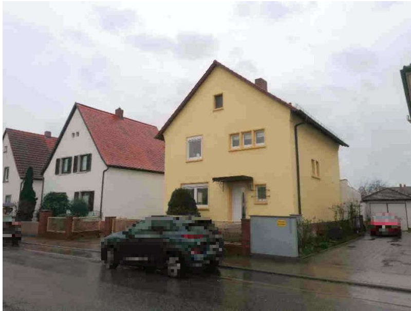
Aufnahme 1: Straßenansicht Nordost
