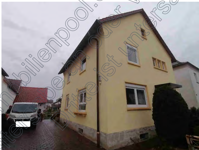
Aufnahme 2: Ostansicht und Hofzufahrt
