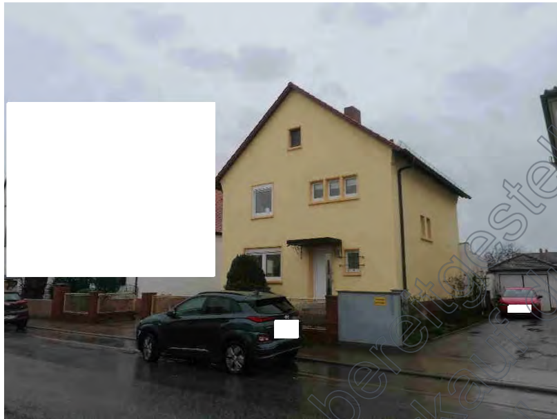
Aufnahme 1: Straßenansicht Nordost
