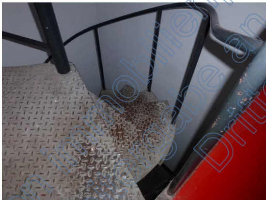
Stahlspindeltreppe zum Untergeschoss
