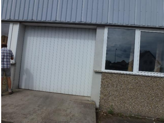
Schiebetor zum Untergeschoss
