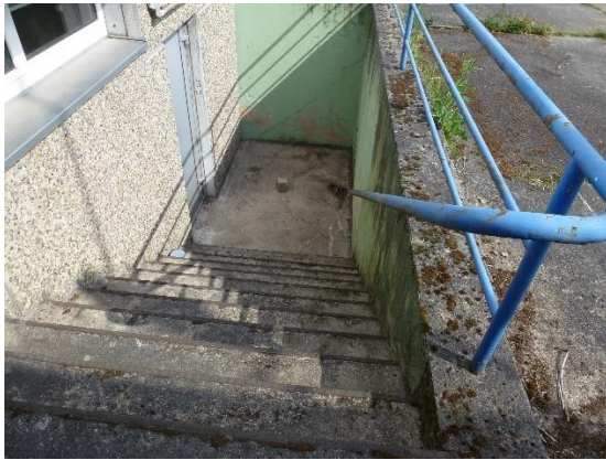
Außentreppe zum Untergeschoss
