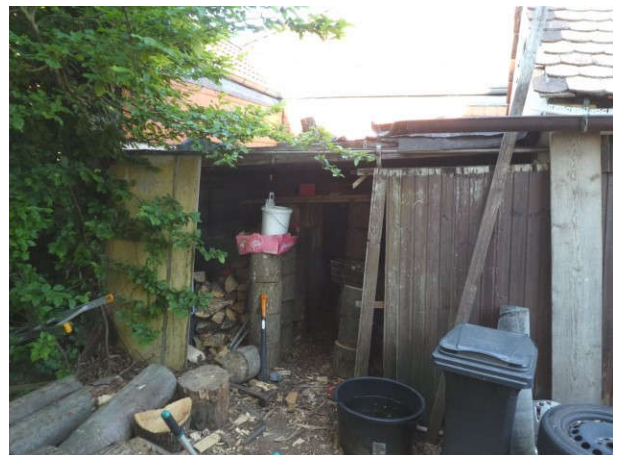
Überdachung südlich der Garage
