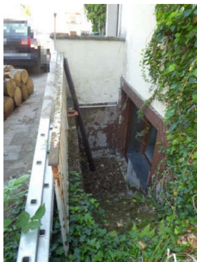
Kelleraußentreppe auf der Westseite
