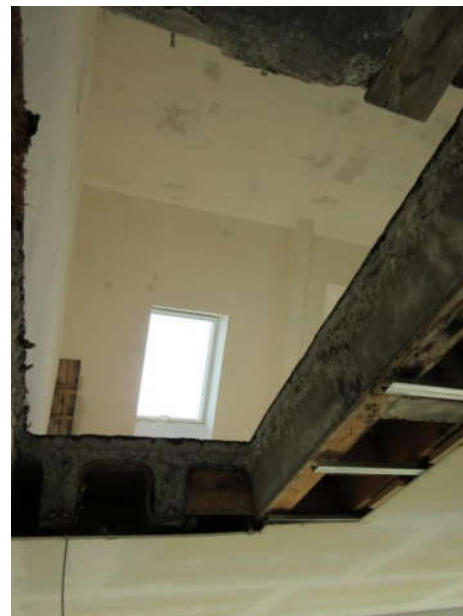
Deckenaussparung zum Dachgeschoss
