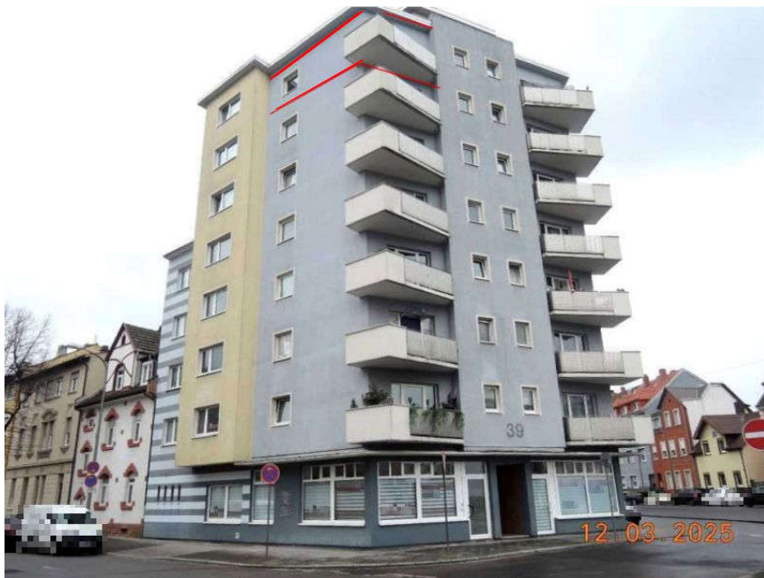
Abb. 1: Straßenansicht aus nordöstlicher Richtung
