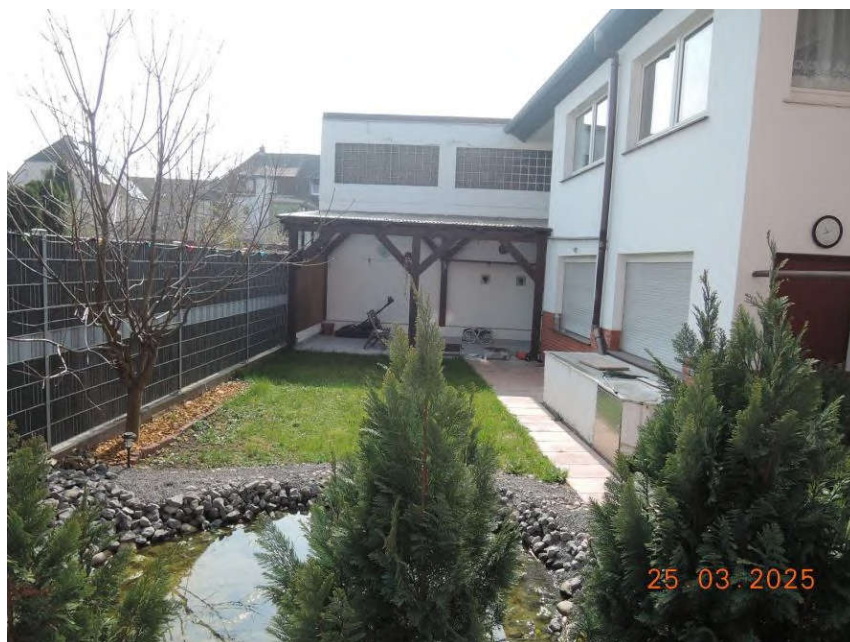
Bild 24: Garten und Seitengebäude
