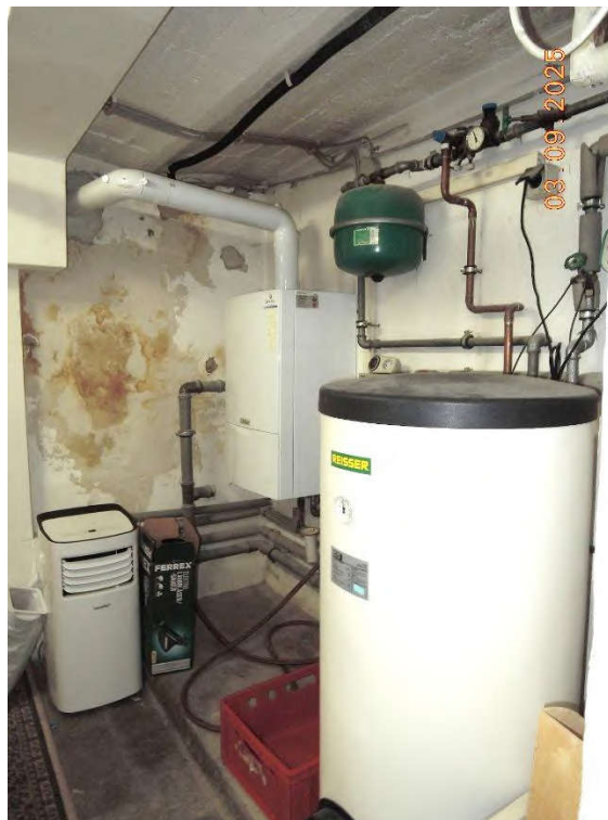
Bild 19: Heizungsraum, Feuchtigkeitsschäden
