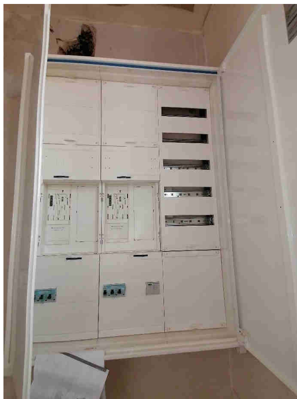
Aufnahme 8: vorbereiteter Zählerschrank
