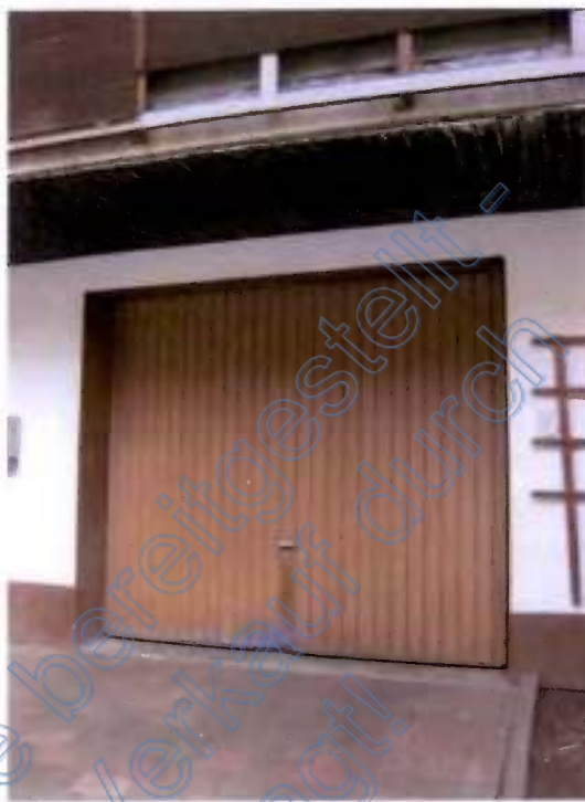
Blick auf die befestigte Hoffläche vor der Einzelgarage
