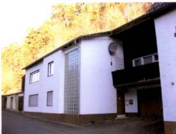
Blick von der Ludwigstraße auf das Einfamilienhaus und Garage
