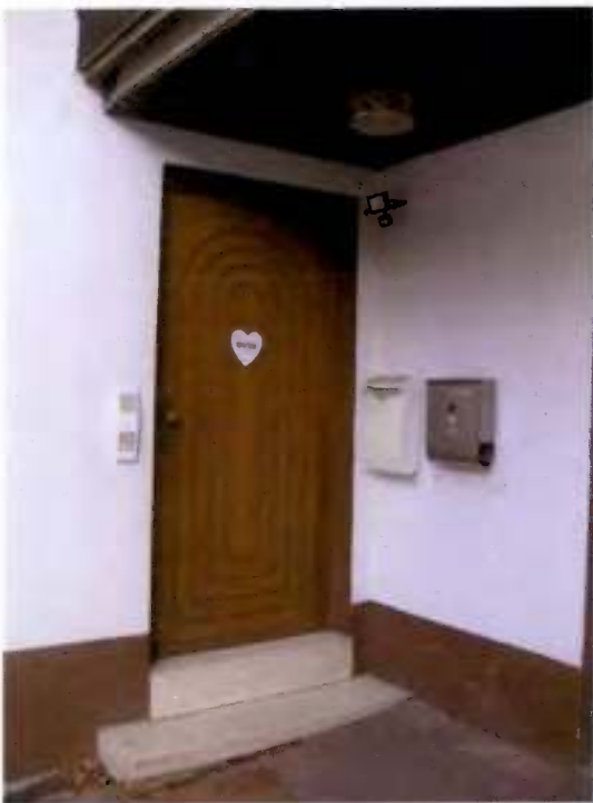
Blick auf den Hauseingangsbereich
