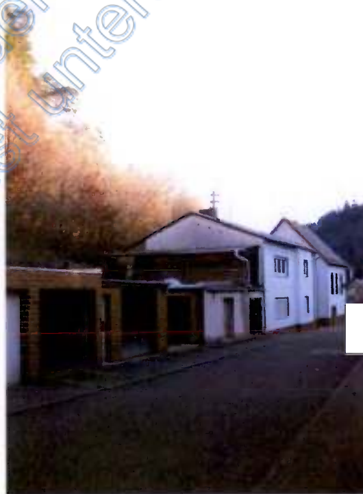
Blick von der Ludwigstraße auf die angebaute Garage
