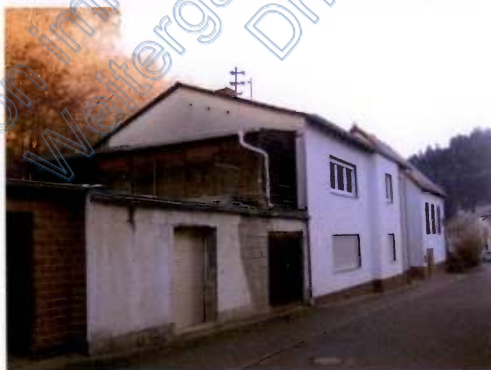
Blick von der Ludwigstraße auf die angebaute Flachdachgarage mit Lagerraum
