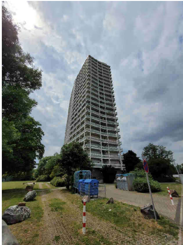
Aufnahme 3: Nordansicht und Müllabstellplatz
