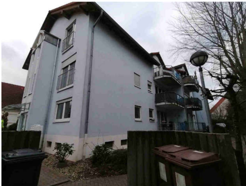
Aufnahme 2: Nordwestansicht mit Hauseingang Nr. 118
