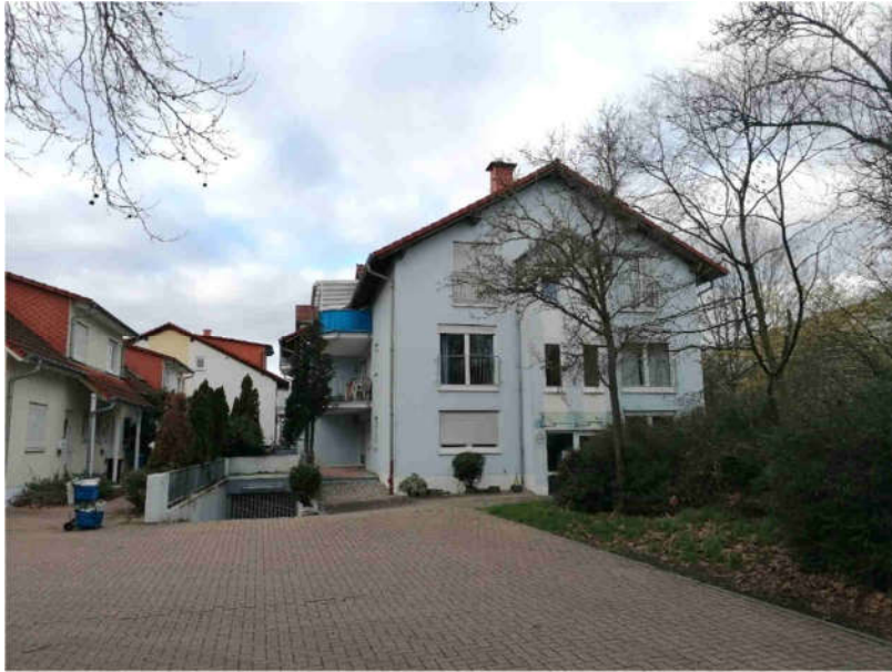
Aufnahme 1: Westansicht mit Tiefgaragenzufahrt
