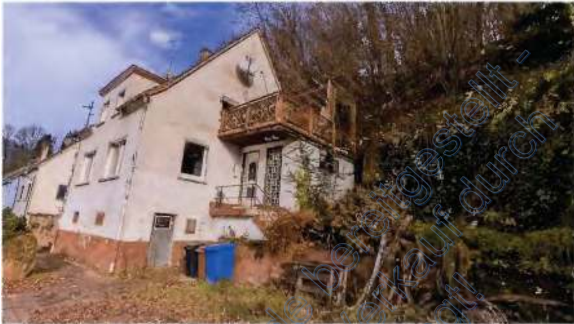
Bild 3: Seitenansicht und Hauseingang
