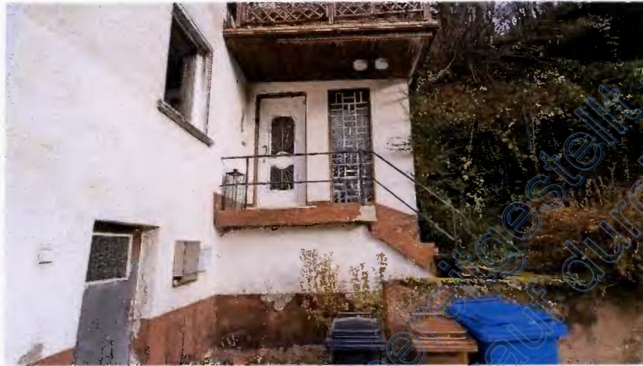
Bild 5: Hauseingang im Erdgeschoss, über Außentreppe erreichbar
