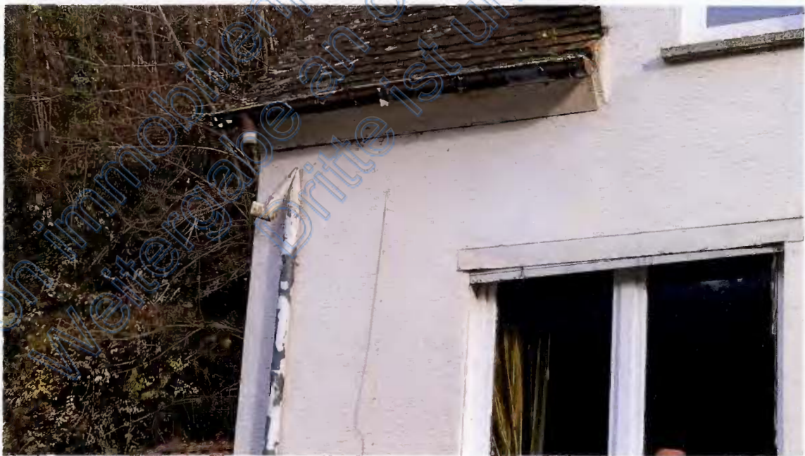
Bild 8: Regenfallrohr abgeknickt
