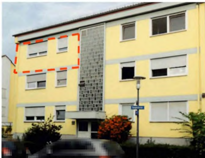
Straßenansicht mit Wohnungsmarkierung (Eigentumswohnung Nr.5)
