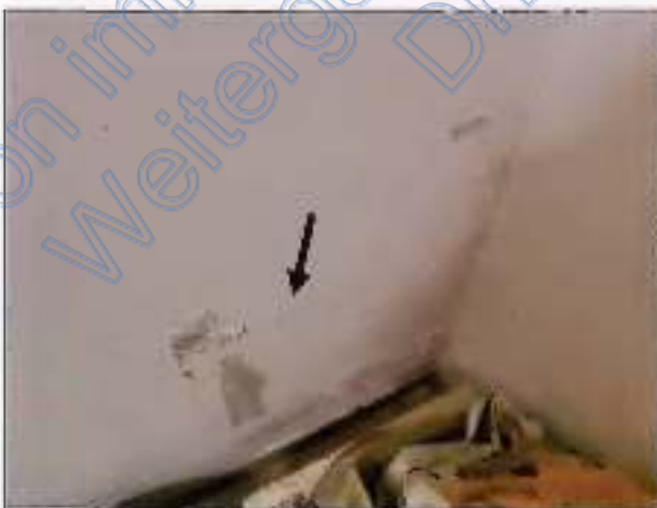
Bild 11: Detailbild Feuchteschäden
