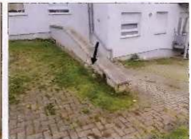
Bild 12: Feuchtschäden außen
