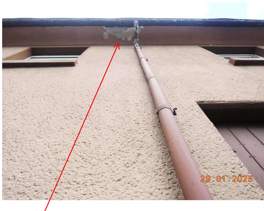
Abb. 5: Feuchtigkeitsschaden Dachunterseite
