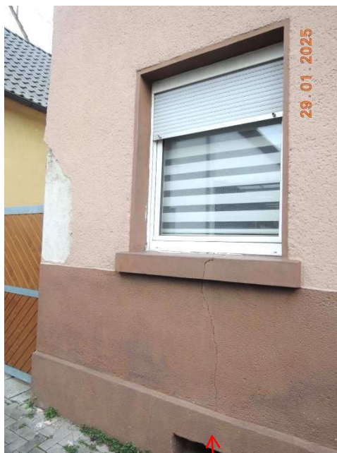
Abb. 2: Detailaufnahme Straßenseite, vertikaler Riss
