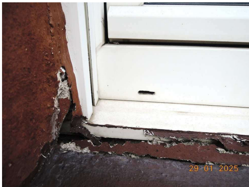
Abb. 6: Schäden an der Außenfassade
