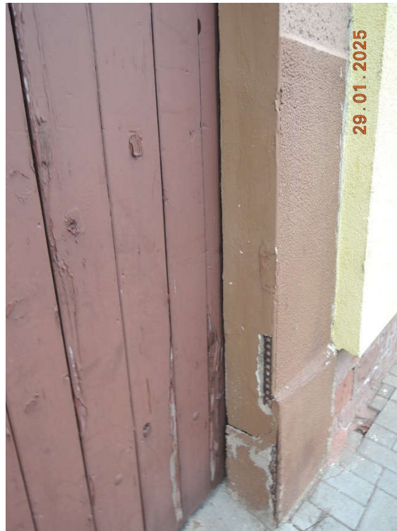
Abb. 3: Schäden am Außenputz, Hoftor
