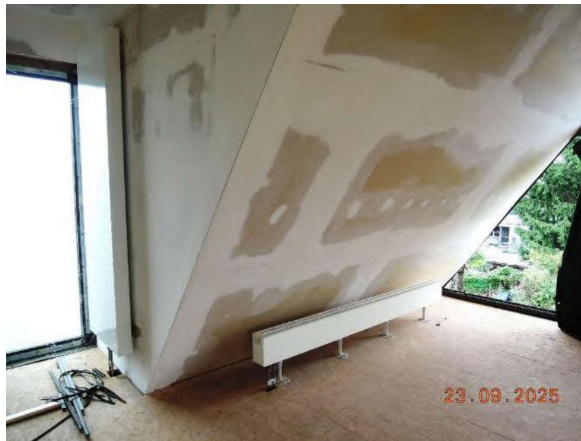
Abb. 27: Innenansicht im Dachspitz
