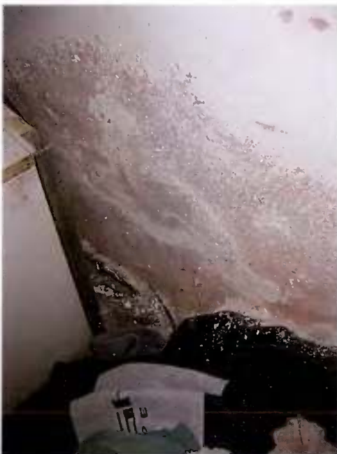
Detail erhebliche Feuchtigkeitsschäden im Sockelbereich der Kelleraußenwand
