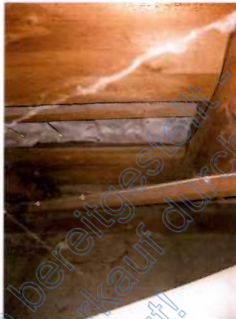
Detail Dacheindeckung und Holzverschalung, ohne Unterspannbahn und Wärmedämmung
