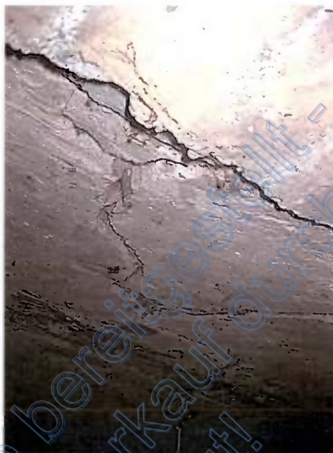
Detail Rissbildung hinteren (Gewölbe)keller
