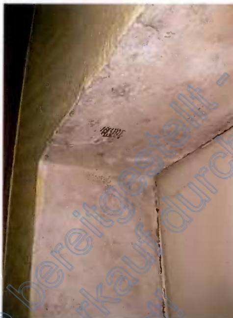
Detail Feuchtigkeitsschaden im Bereich Tür zur angebauten Einzelgarage
