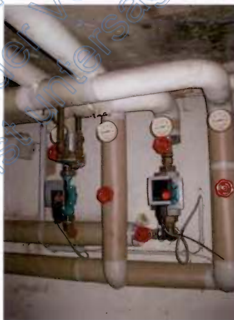
Detail gedämmte Leitungen und Heizungspumpen
