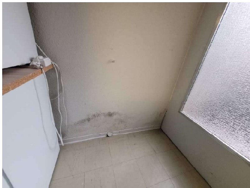
Aufnahme 16: Schimmel im Sockelbereich Kellerausgang
