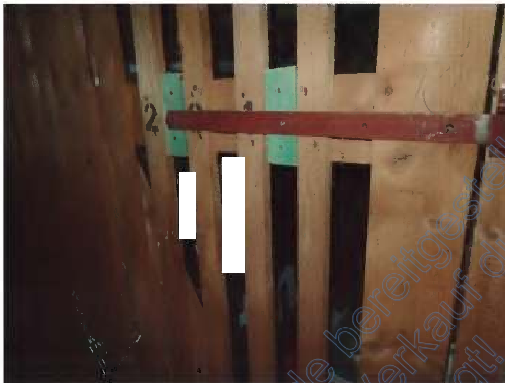
Kellerabteil mit der Markierung 201
