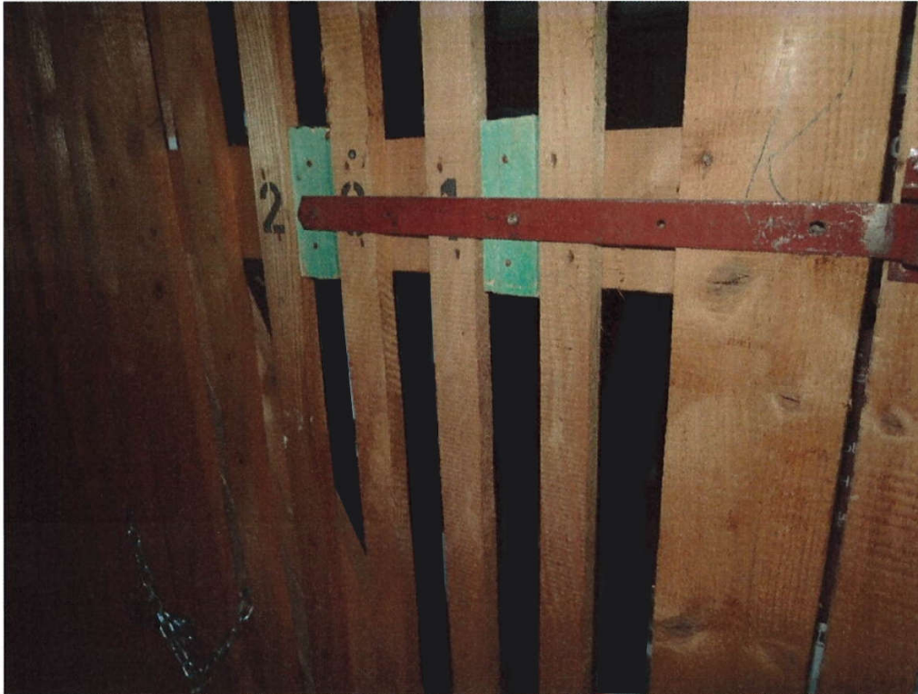
Kellerabteil mit der Markierung 201
