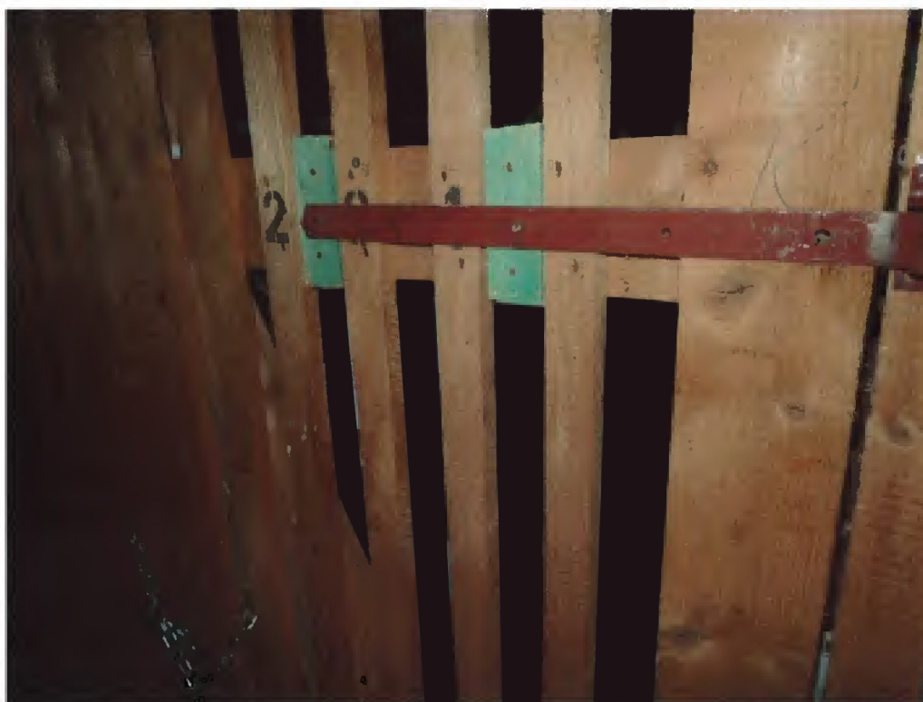
Kellerabteil mit der Markierung 201
