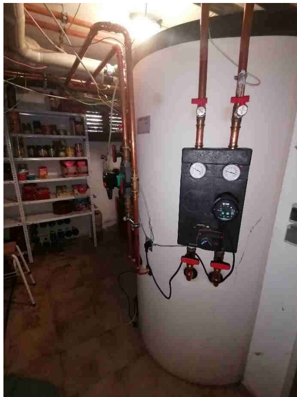
Aufnahme 10: Warmwasserspeicher
