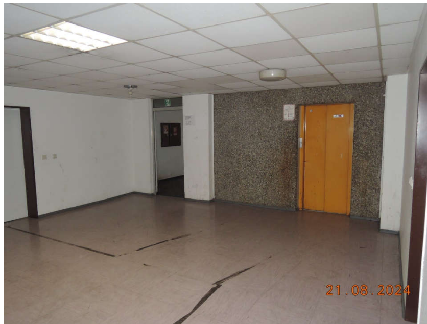
Abb. 7: Flur und Aufzug 5. OG
