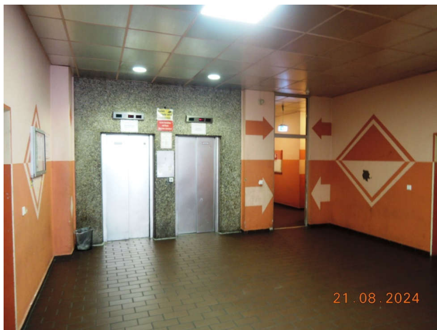
Abb. 4: Eingangsbereich und Aufzüge
