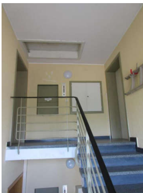
Treppenhaus Bereich Dachgeschoss
