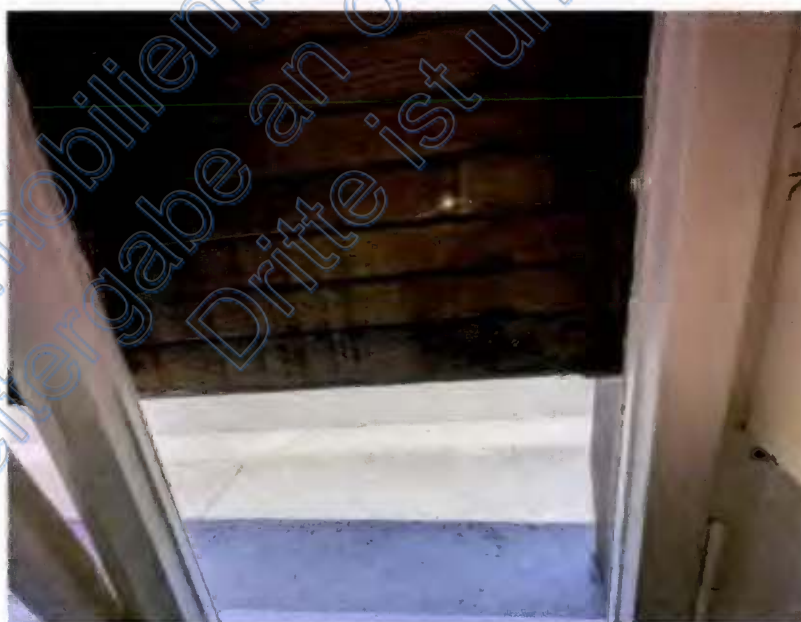
Bild 14: Fenster straßenseitig, Holzfenster mit Einfachverglasung und Holzrollladen
