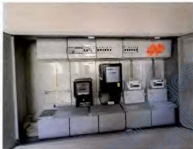
Bild 15: gemeinschaftlicher Zählerschrank mit Sicherungen
