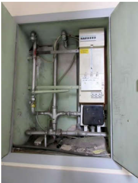
Abschlussstür der Wohnung Nr. 8
