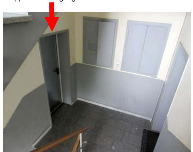
Abschlussstür der Wohnung Nr. 8
