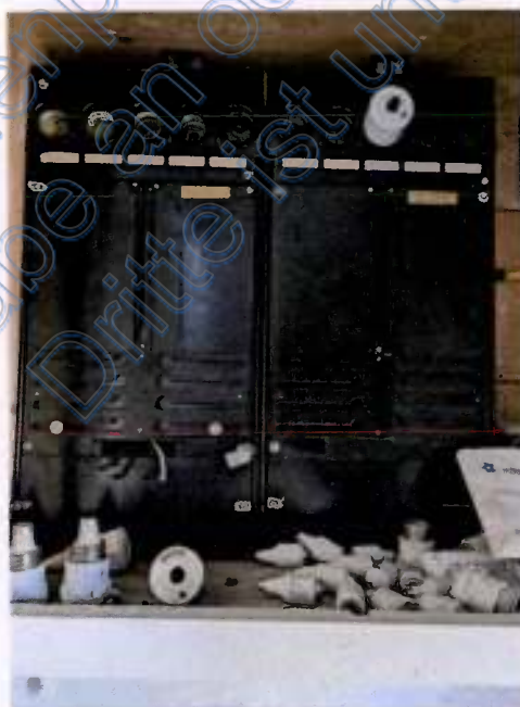
Bild 14: Zählerkasten, ohne Sicherungen und Zähler
