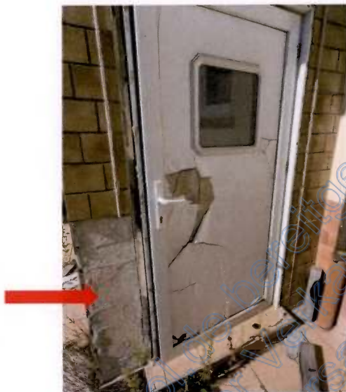
Bild 9: Garagentür zum Garten, fehlende Sockelfliesen, Tür beschädigt
