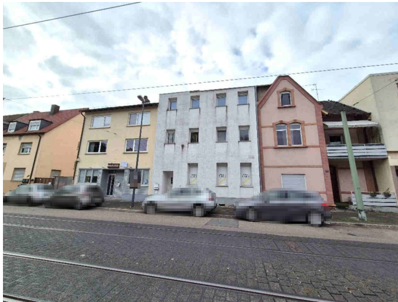
Aufnahme 1: Nordansicht Carl-Bosch-Straße
