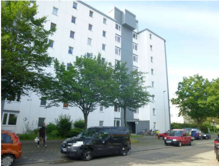
Bild 1: Straßenansicht Haus Nr. 9
