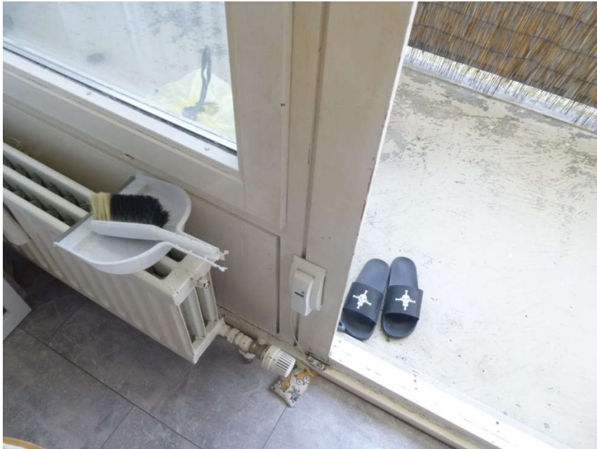
Bild 7: Zugang zur Loggia
