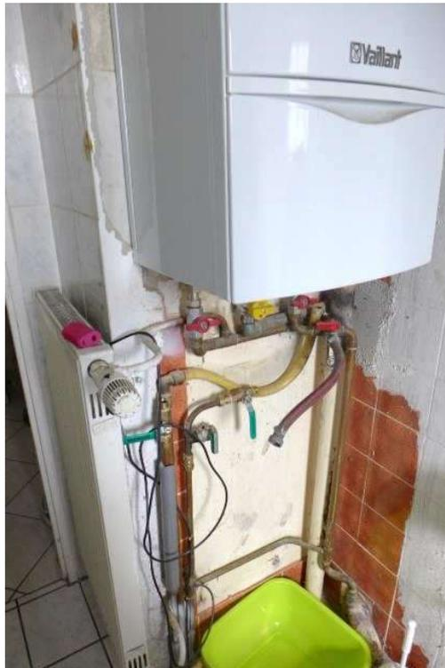
Bild 5: Gas-Etagenheizung im Bad (defekt bzw. nicht angeschlossen)
