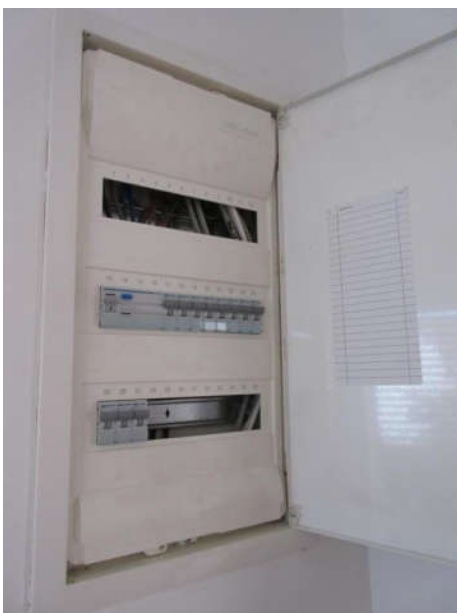
Elektro-Unterverteilung im Obergeschoss rechts
