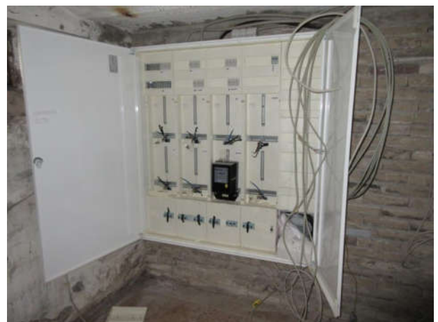
Elektro-Hauptverteilung im Kellergeschoss
