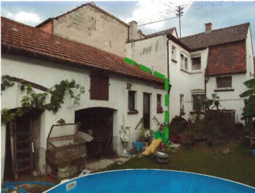
Rückansicht (Einfamilienhaus mit Anbau und Schuppen)
