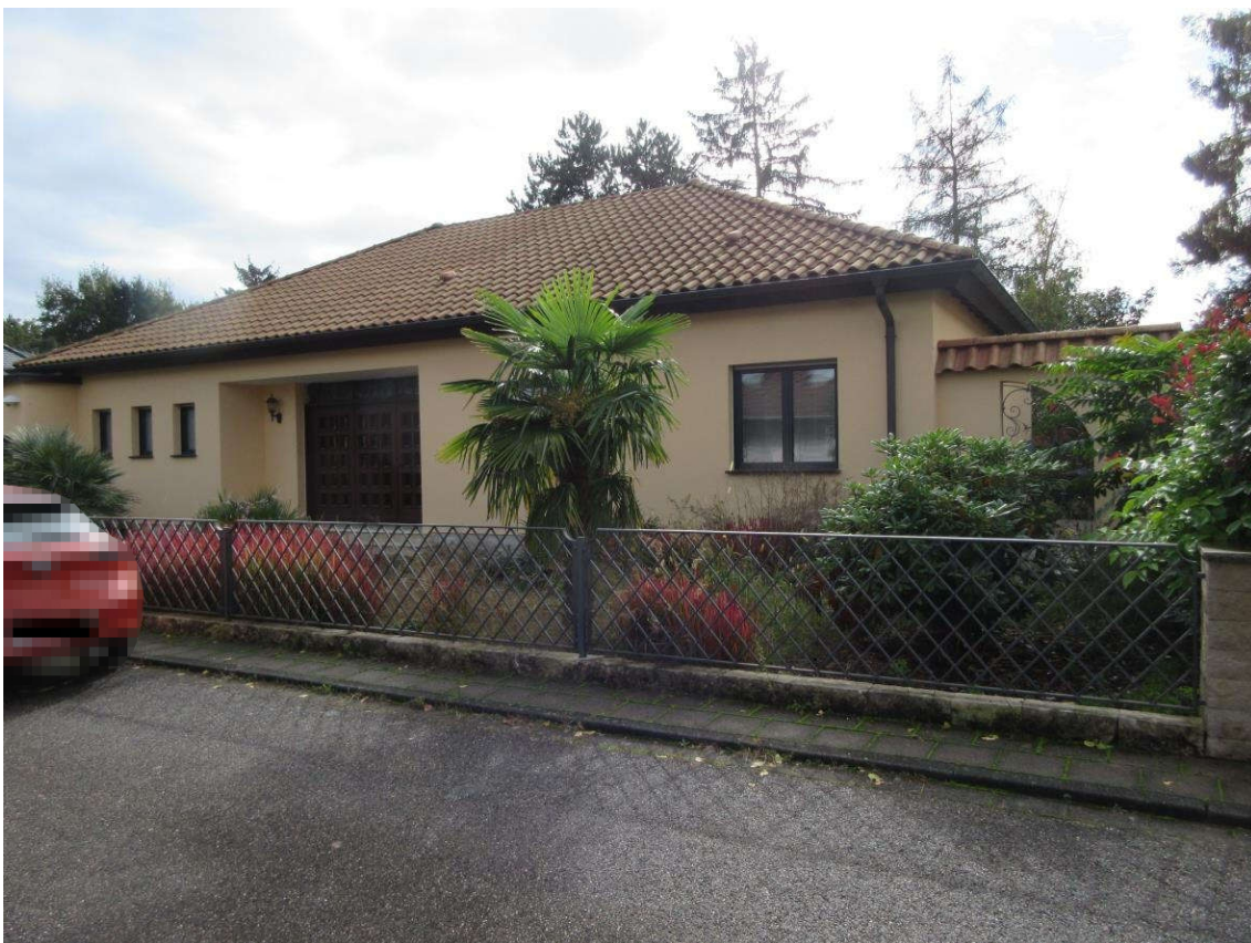
Straßenansicht Hockenheimer Straße 23
