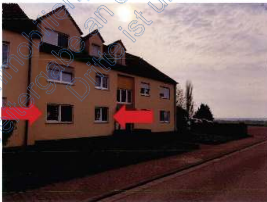
Bild 2: Blick auf die Wohnungseigentumsanlage aus nordwestlicher Richtung
